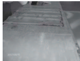
14. ábra. Gumiőrlemény tartalmú zajszigetelő lemezek ragasztóval kent és ragasztott állapotban
