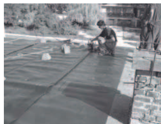
15. ábra. Tetőszigetelés gumiőrlemény tartalmú lemezek forrólevegős hegesztésével
