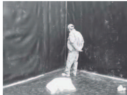
16. ábra. Hűtő- és csurgalékvíz tároló vasbeton medence bélelése részben gumiőrlemény tartalmú lemezzel. Középső képen a felül lévő FLEXIT- és HDPE-lemez helyszíni közösítése
