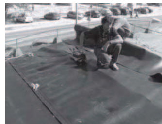
15. ábra. Tetőszigetelés gumiőrlemény tartalmú lemezek forrólevegős hegesztésével
