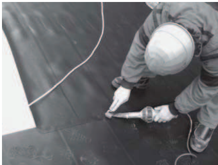
16. ábra. Hűtő- és csurgalékvíz tároló vasbeton medence bélelése részben gumiőrlemény tartalmú lemezzel. Középső képen a felül lévő FLEXIT- és HDPE-lemez helyszíni közösítése
